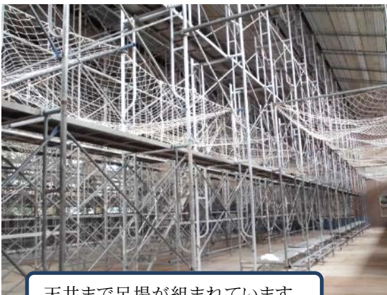
天井まで足場が組まれています。
